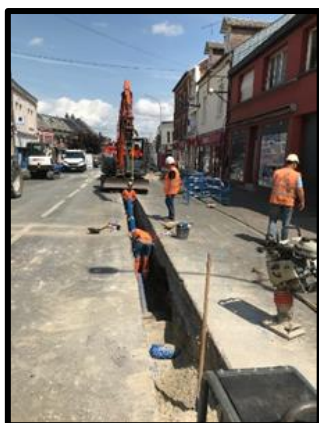
RENOUVELLEMENT DU RESEAU D'EAU POTABLE ET DES BRANCHEMENTS
