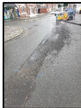
RENOUVELLEMENT DU RESEAU D'EAU POTABLE ET DES BRANCHEMENTS
