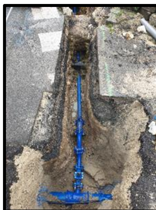
RENOUVELLEMENT DU RESEAU D'EAU POTABLE ET DES BRANCHEMENTS
