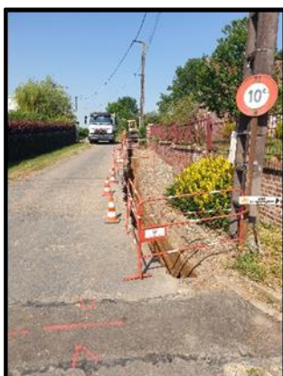
RENOUVELLEMENT DU RESEAU D'EAU POTABLE ET DES BRANCHEMENTS
