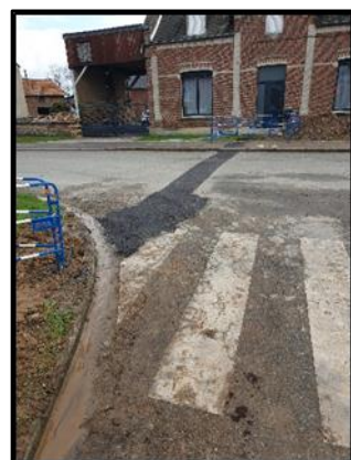
RENOUVELLEMENT DU RESEAU D'EAU POTABLE ET DES BRANCHEMENTS
