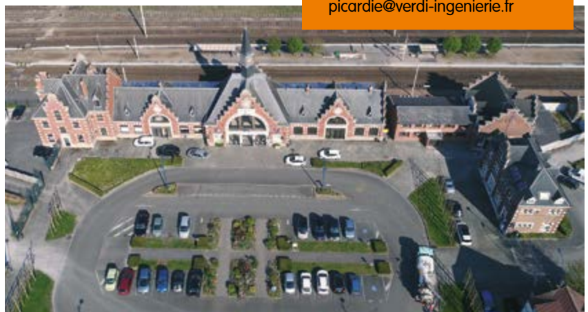
Exemple d'aménagement conçu par Verdi Picardie : la Place de la gare d'Albert
