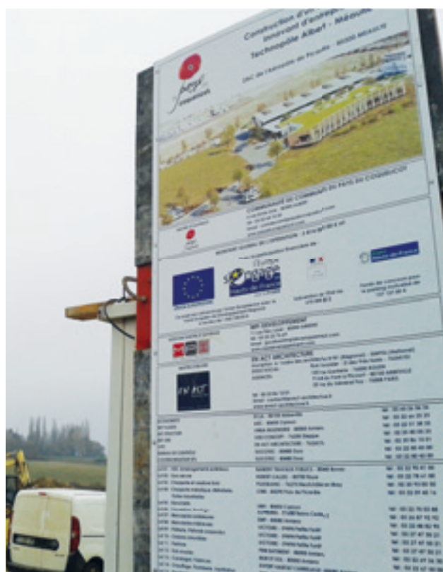
Chantier pour l'hébergement innovant d'entreprises
