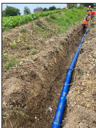
Interconnexio n FRICOURT- MAMETZ
