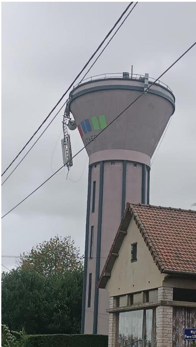
Un bout du campanile de la coupole sur lequel était placée l'antenne a été endommagé. Suite à ce constat, nous avons fait passer un drone pour contrôler l'état de la structure génie civil du réservoir, et aucun autre dégât n'a été détecté sur la structure. Il a été convenu que le garde-corps endommagé soit réhabilité par l'opérateur téléphonique au moment des travaux de mise en place de la nouvelle antenne.
