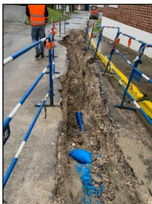
Rue du Major Raper FRICOURT
