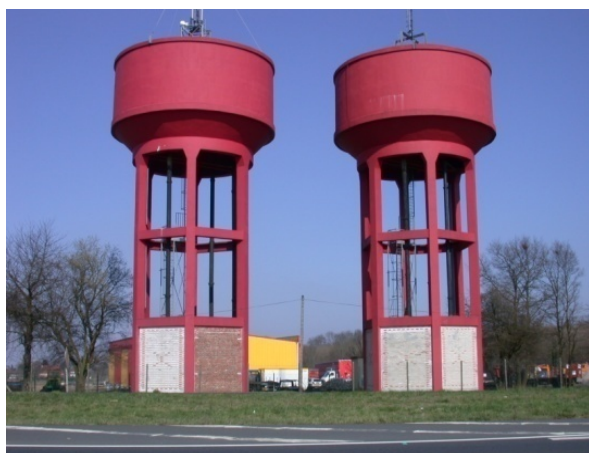
Réservoirs de Le Quesnel
